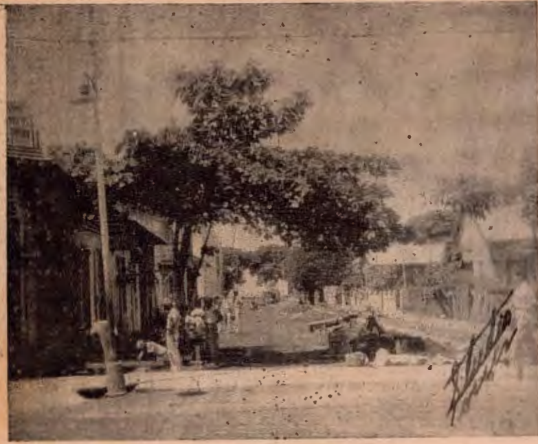
Otro aspecto no menos interesante de este esfuerzo titánico; nótese la brecha de 200 varas abierta en la calle, desde el Studio Torres, hasta el Paseo Guevara en la calle Fco. de P. Amador, antigua Calle Piedra
