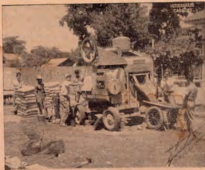
Máquina batidora de concreto del equipo mecánico de la Municipalidad, empleada con éxito en los trabajos de pavimentación de la ciudad
